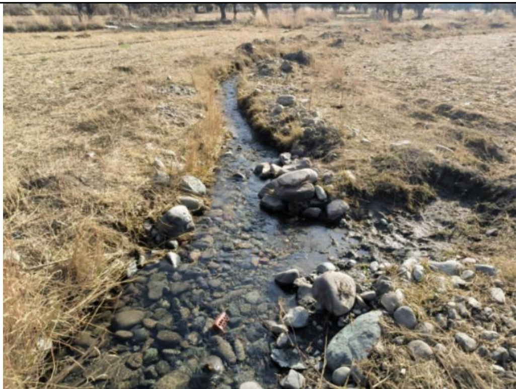
西沟乡斗渠未衬砌，渗漏损失严重
