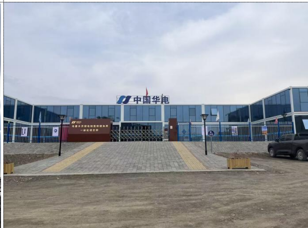
制氢站 110kV 降压站
