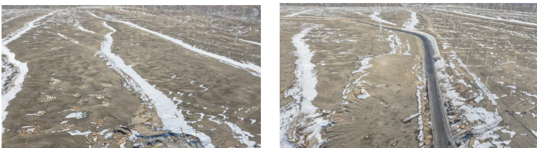
祁家沟~建筑园 110 千伏线路工程沿线现状
