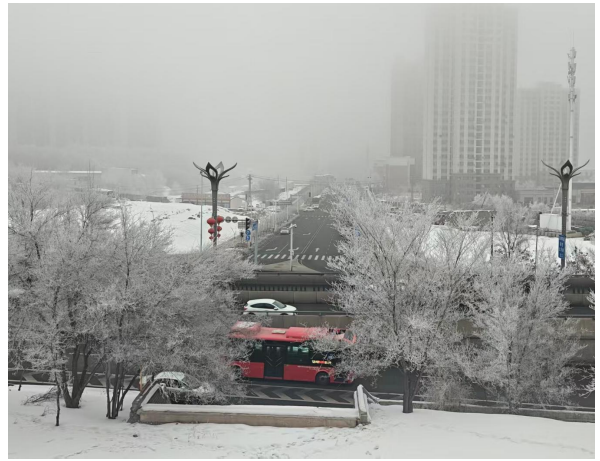
跨越苏州路段现状
