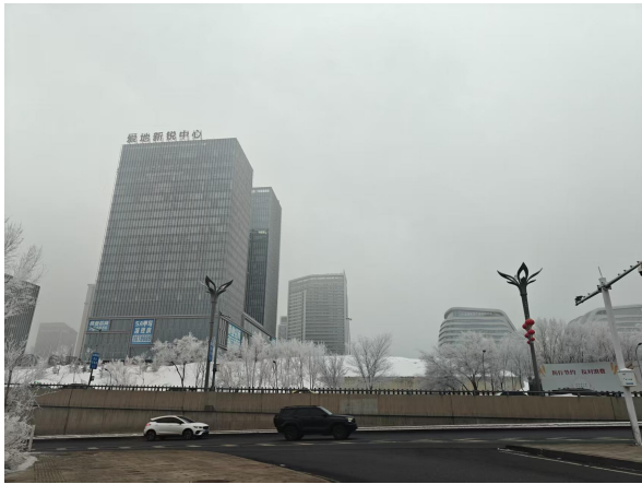
跨越苏州路段现状
