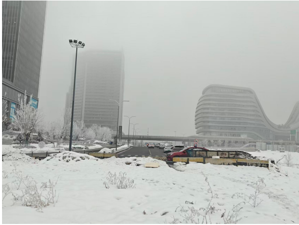
项目起点（荣盛六街与高铁北五路交叉口）
