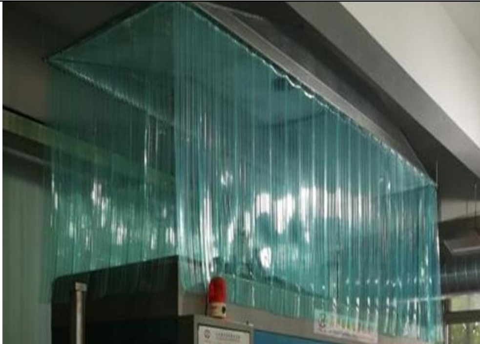
图4-1 集气罩加装密封软皮帘示意图
