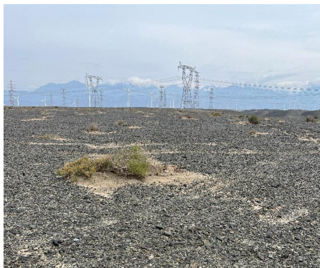
本项目出线端升压汇集站站址现状
