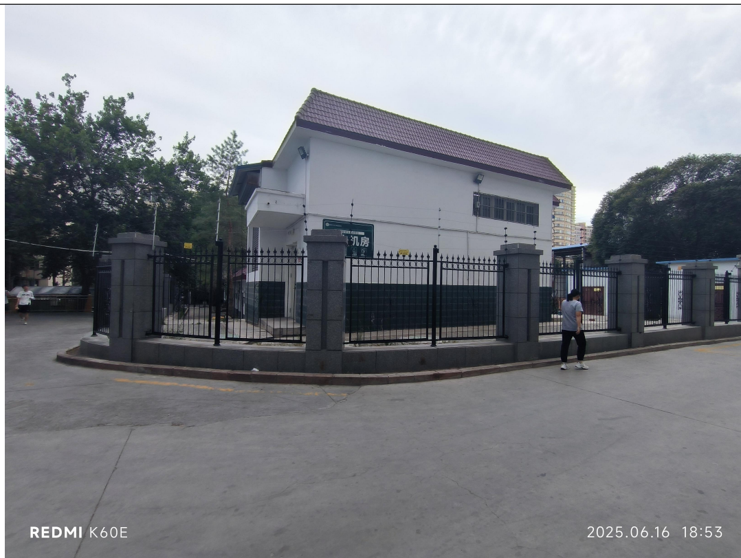
图 9-6 污水处理站现场图
