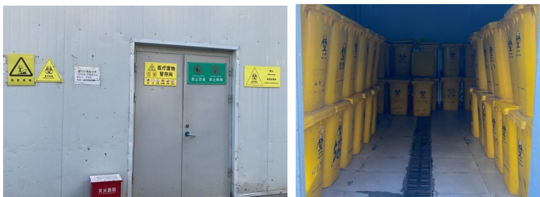
图 4-2 医疗废物贮存间
