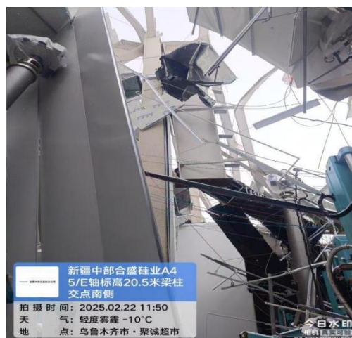
图 16 5/E 轴标高 20.5 米梁柱交点南侧
