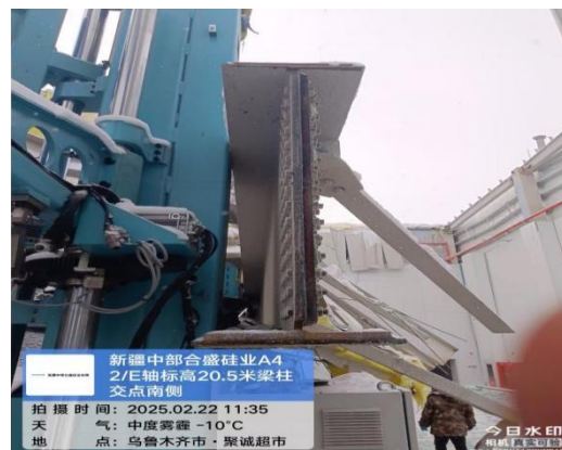
图 14 2/E 轴标高 20.5 米梁柱交点南侧 (2)
