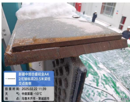
图 13 2/E 轴标高 20.5 米梁柱交点南侧
