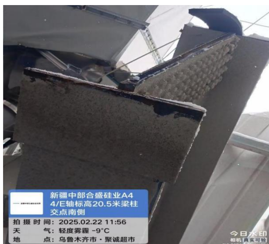
图 15 4/E 轴标高 20.5 米梁柱交点南侧
