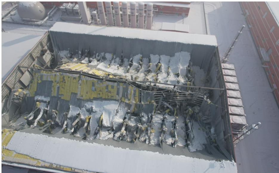
图 1 事故厂房俯视图
