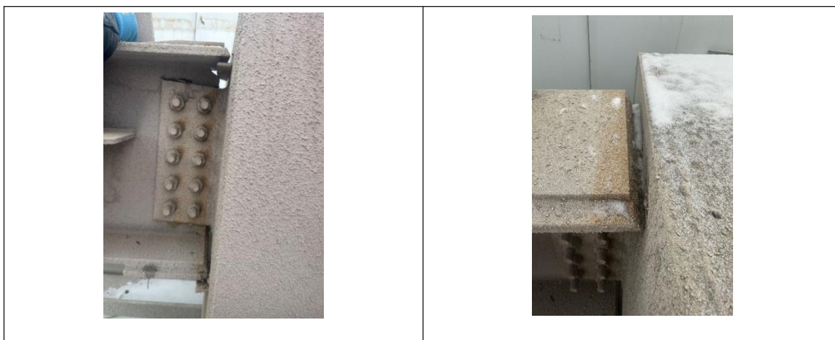
图 11 10/G 轴钢柱与 10/G~H 轴钢梁节点
