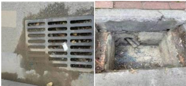
图 6.2-4 雨水口常见病害示意图
