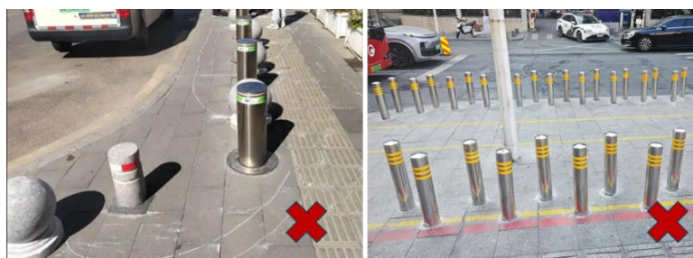
图 6.5.1 阻车柱设置不合理示意图
