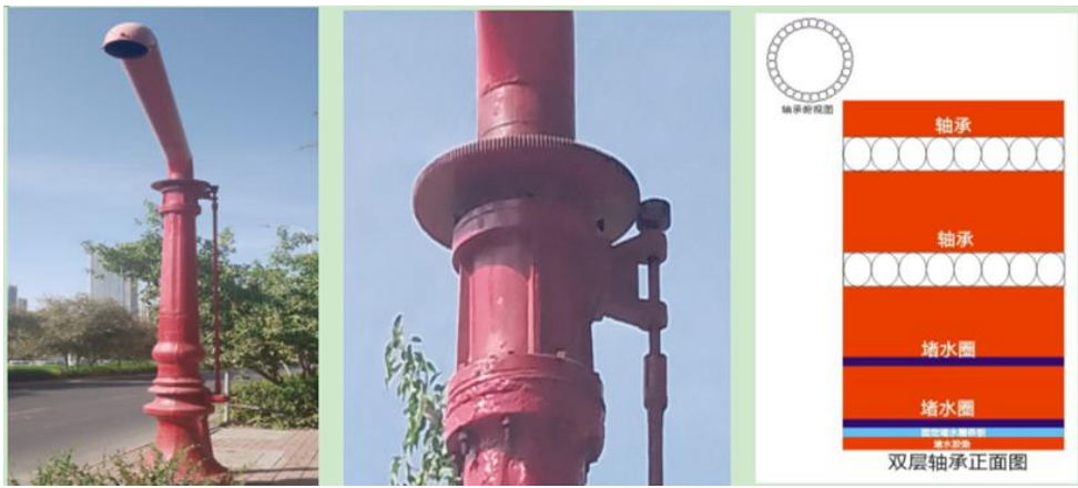
图 6.1-1 消防水鹤旋转机构局部改造示意图
