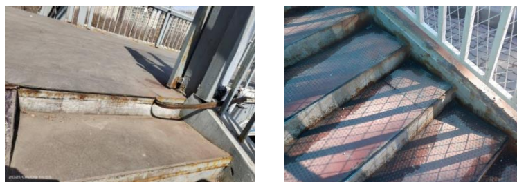
图 6.8-4 梯道防滑条脱落、梯道板锈蚀
